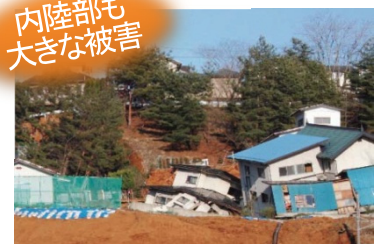
家屋被害の状況 (福島市伏拝地内)
