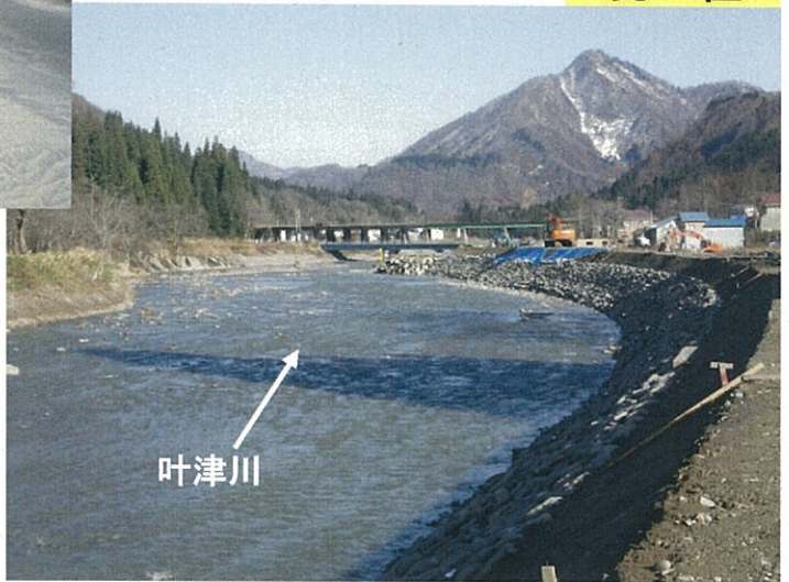
堅盤橋上流 （只見町大字叶津地内） 自然石護岸工事が完了。 （平成24年12月3日撮影）
