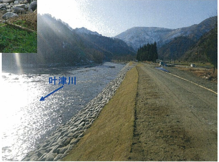
3工区(只見町大字叶津地内) 自然石護岸工事が完了。 (平成24年12月3日撮影)
