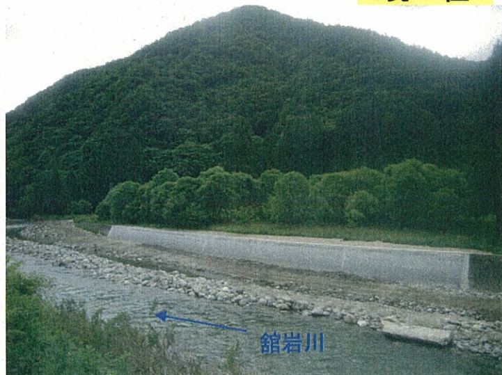
護岸工施工中（進捗率約75%）（平成24年6月25日撮影）
