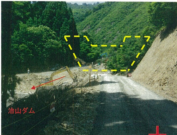
上流に建設予定の治山ダム<基礎掘削中>:只見町大字熊倉地内(平成24年6月29日撮影)
