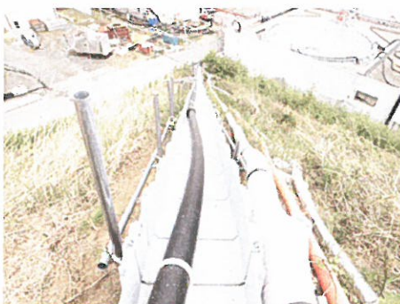
4月29日SPT～廃液供給タンク完了
