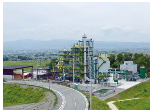
木質バイオマス発電施設 ((株)グリーン発電会津
