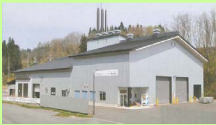
木質バイオマス発電施設
